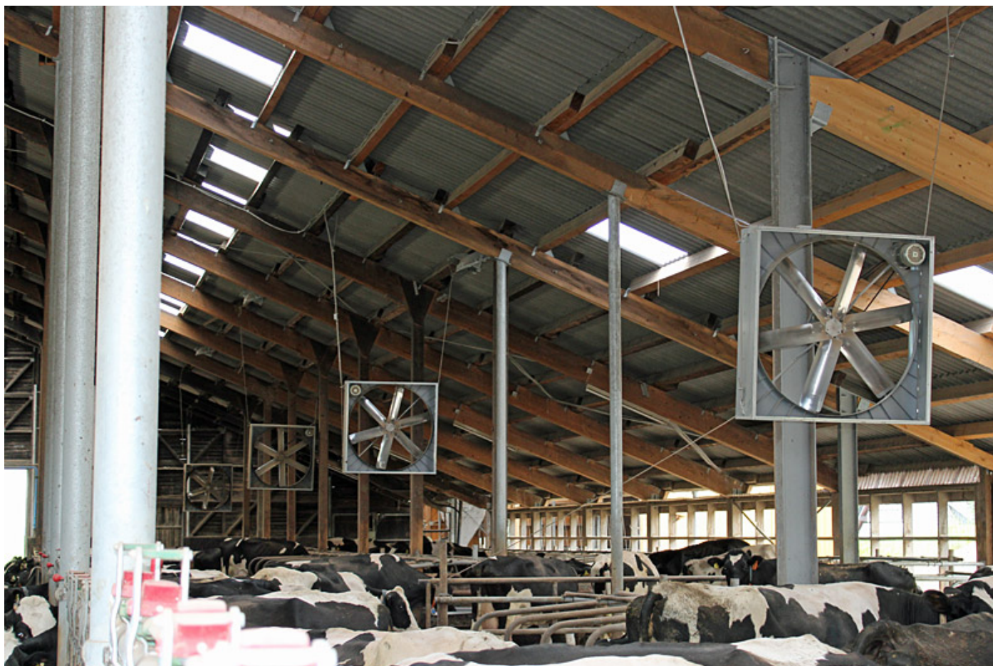
Рисунок 1. Осевые вентиляторы расположены последовательно вдоль оси коровника. Расположив их на высоте 2,7 м над проходами, вы можете обойтись без защитной решетки и, таким образом, увеличить эффективность.
